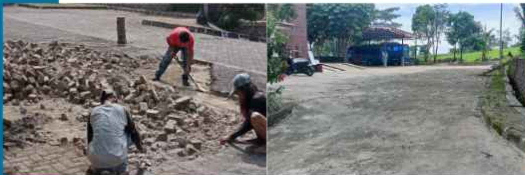
Gambar 37 Perbaikan Paving Blok dan Jalan
